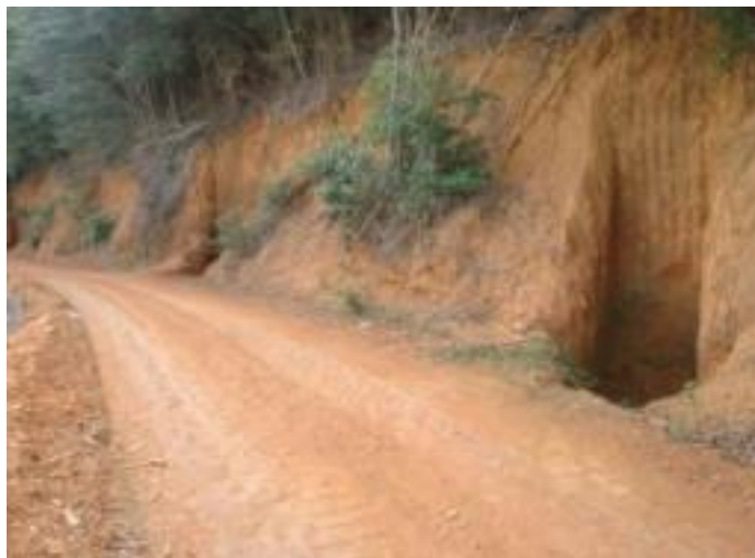
Figura 6.5: Caixas secas implantadas em estrada vicinal no município de São Roque do Canaã - ES
